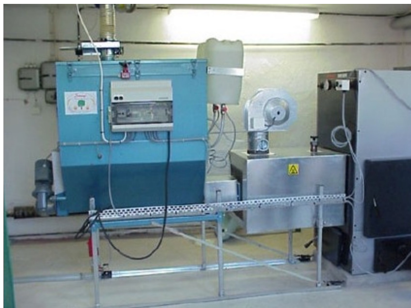
Foto 1. Uniwersalny palnik na biomasę FARMHEAT firmy SCANBIO.
